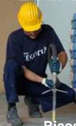
Ricostruzione del piano di appoggio
