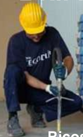
Ricostruzione del piano di appoggio
